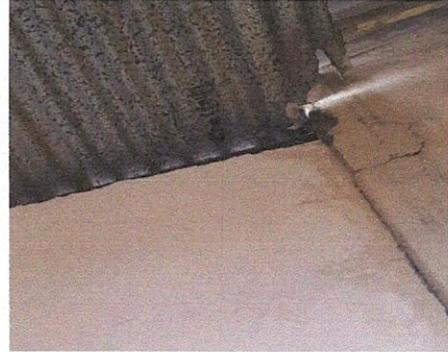
Foto 2: Antes, Lamina deteriorada
